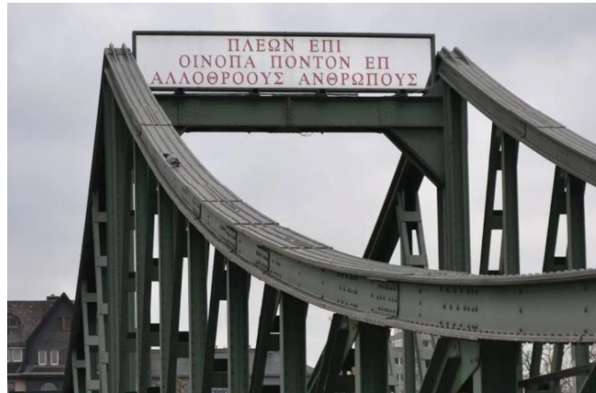
Γέφυρα του ποταμού Μάιν -παραπόταμου του Δούναβη- στην Φρανκφούρτη
